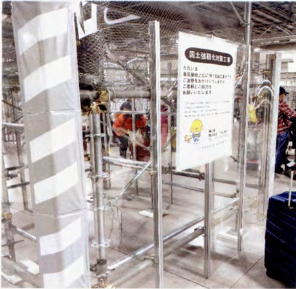
施工架圍安全網及塑膠板隔離
