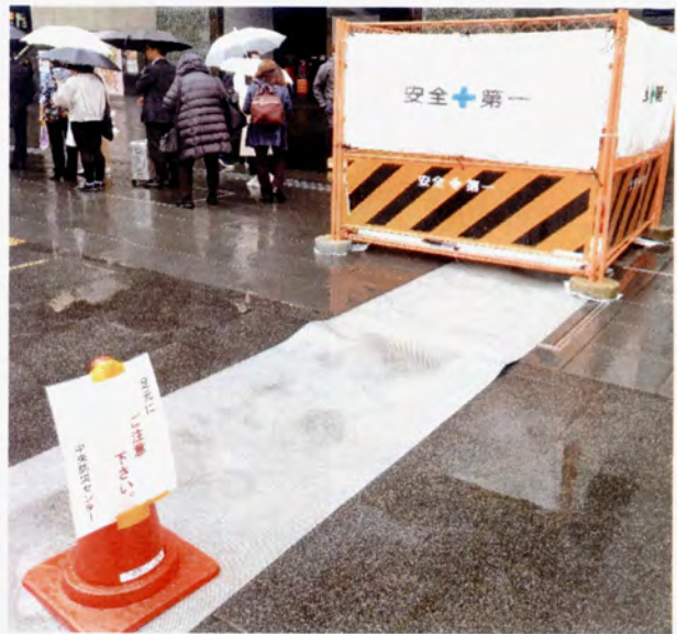
電線覆蓋及提醒用路人注意腳下
