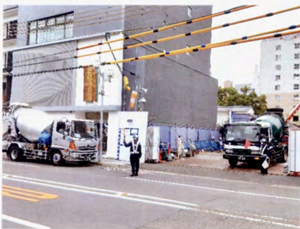
工地車輛進出人員交通指揮
