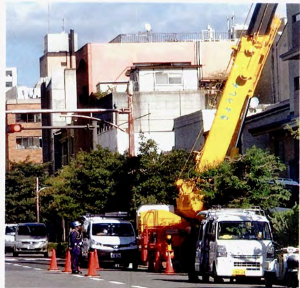
吊掛作業範圍確實圈圍
