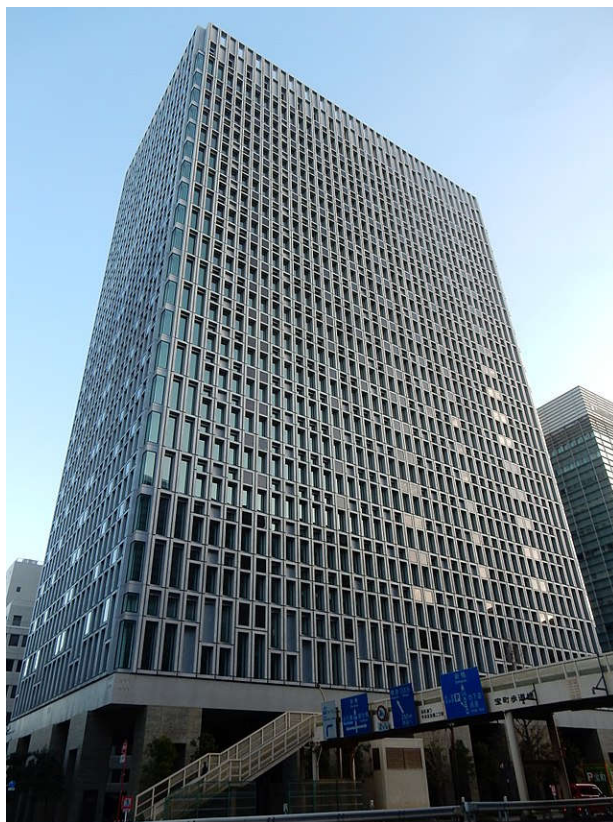
圖 41 清水建設總部大樓外部照
