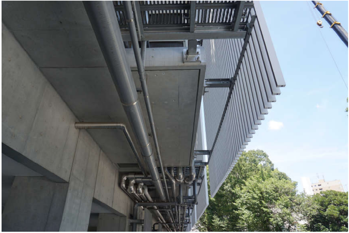
圖 38 可動式百葉之雙層外牆構造(機構端)
