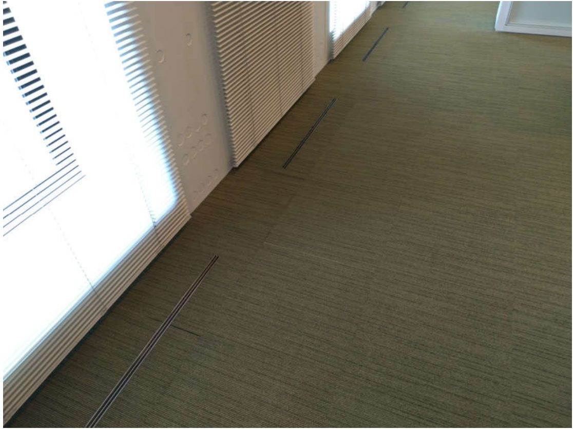
圖 43 清水建設總部大樓除採放射式輻射空調設計外，另在室內空間外周區設置地板出風調節室內環境
