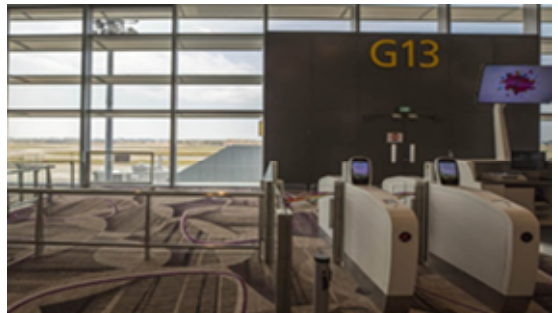
圖 5.2.2.9 設有人工及設備登機閘門
