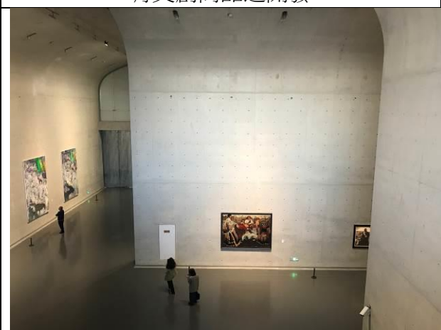
龍美術館-內部展覽空間極高挑，且採預鑄清水模，燈光僅能從天花板頂端打光，換燈應為一大工程
