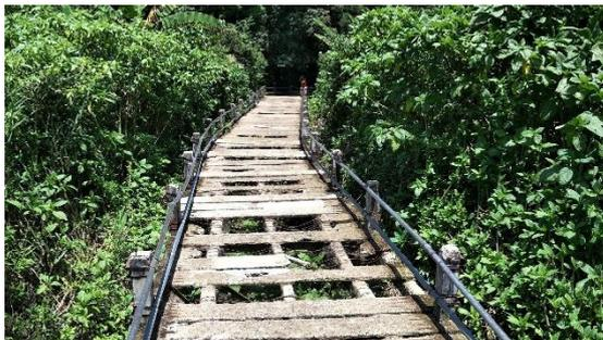
圖 46、高架棧道破損嚴重
