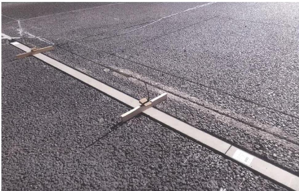
圖 3-3-19 動態地磅施工中狀況
