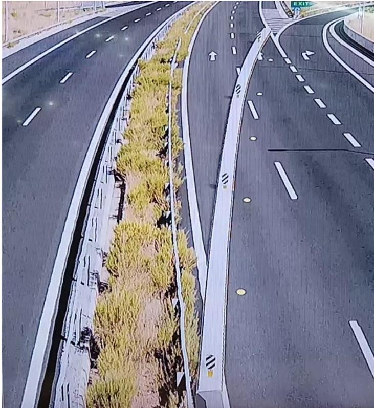
圖 3-3-17 匝道口平移式活動護欄(將匝道封閉狀態)
