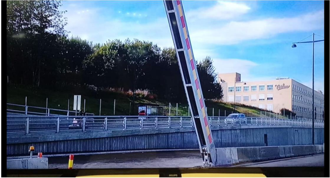
圖 3-3-13 中央柵欄式活動護欄(開啟狀態)
