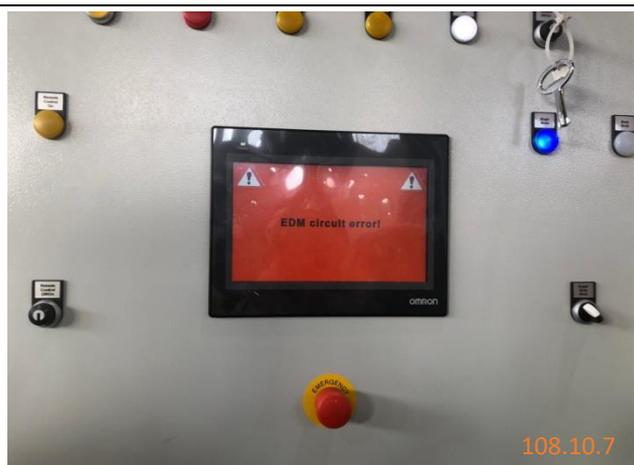
圖 52: 5.0 控制盤功能測試：
