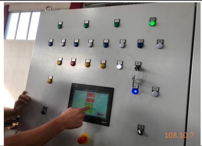
圖 54: 5.0 控制盤功能測試：
