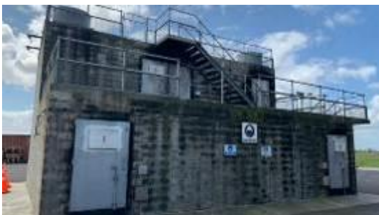
圖 88：船艙空間濃煙訓練設施
