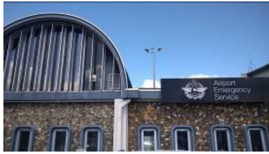
圖 76：機場緊急事故服務辦公室
