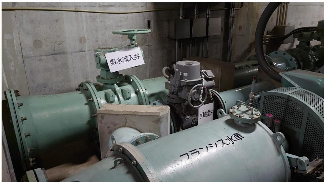
圖 19.小水力發電水車
