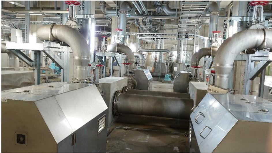
圖 14. 薄膜設備下方管線廊道
