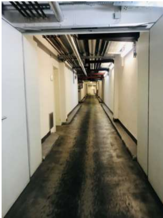
圖 125、標誌完成的核醫藥物藉由地下通道從核醫藥局運送到醫院本館核醫科病房進行分裝。 (照片為作者於巴特貝爾卡中央醫院拍攝)
