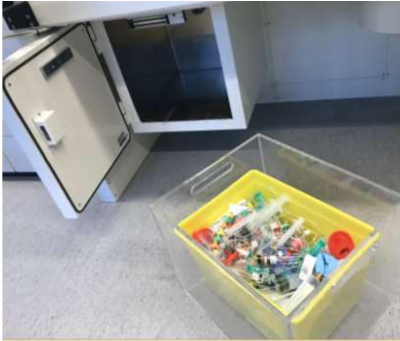
圖68、凱薩琳醫院核醫藥局之放射性廢棄物收集桶，裝置於壓克力箱中再置入小鉛櫃中，待其活度衰退至無法測得，再以一般醫療廢棄物處理辦法處置。(照片為作者參訪凱薩琳醫院時拍攝)
