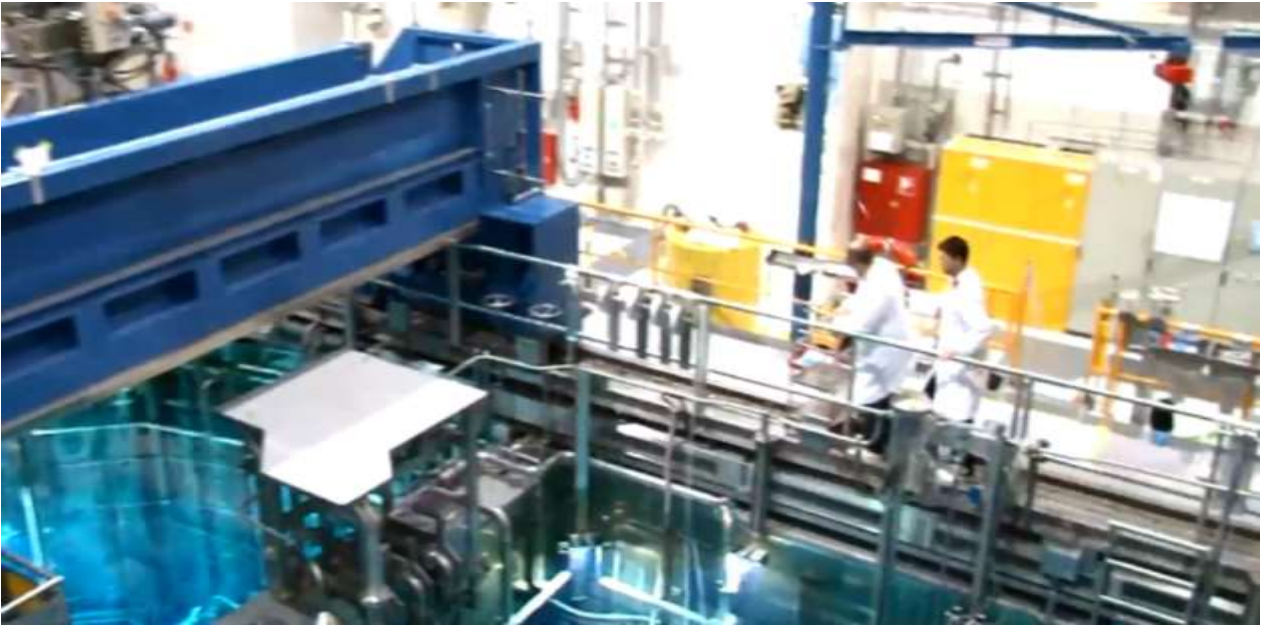
圖21、TUM研究人員將裝有Yb-176之容器投入連通管入口。(圖片摘錄自ITG介紹影片)
