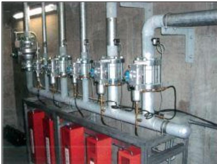
圖 20：氣體滅火設備
