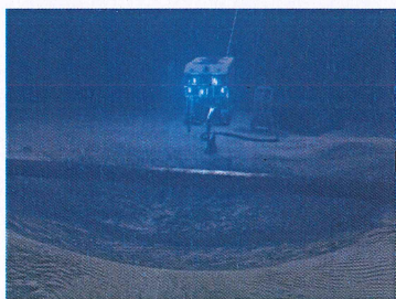
1. 清出作業空間使管線裸露
