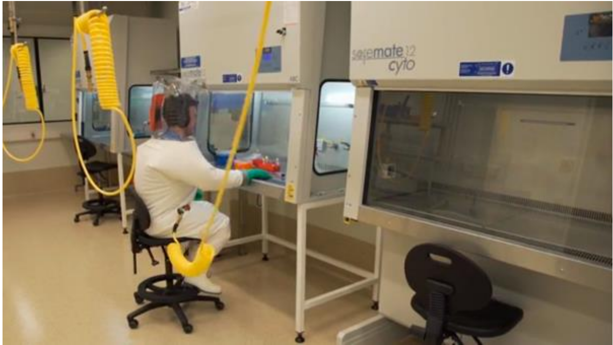
圖 17. PC4 實驗室內生物安全操作櫃。
