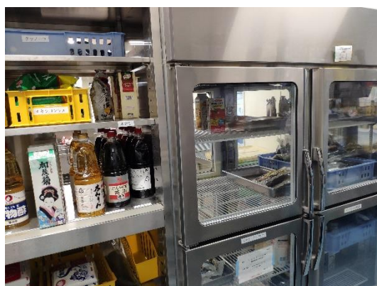
圖 3-13 雙通櫃存放雜貨與前處理完成之食材，方便烹調區取用
