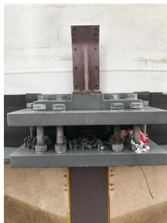
圖 19 螺栓固定塔架底部
