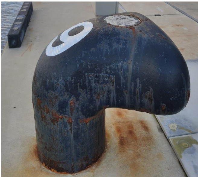
圖 40. 濟州西歸浦港共兩個泊位，「11-12(西)」泊位有 25 根 150 噸繫船柱；「21-22(南)」泊位有 18 根 150 噸繫船柱。
