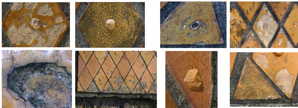
路思義教堂磁磚釉層剝落、穿孔、起甲、微生物汙染等劣化現象（筆者攝）
