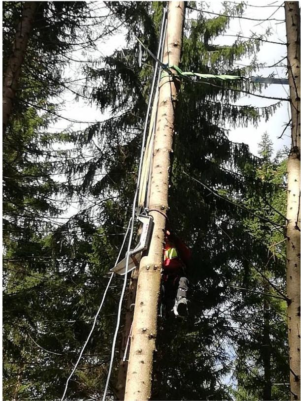
圖 142 架設中間柱的鞍座
