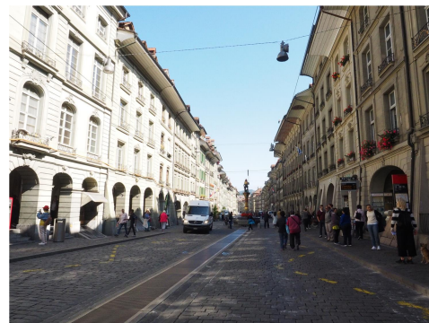
騎樓迴廊人行空間
