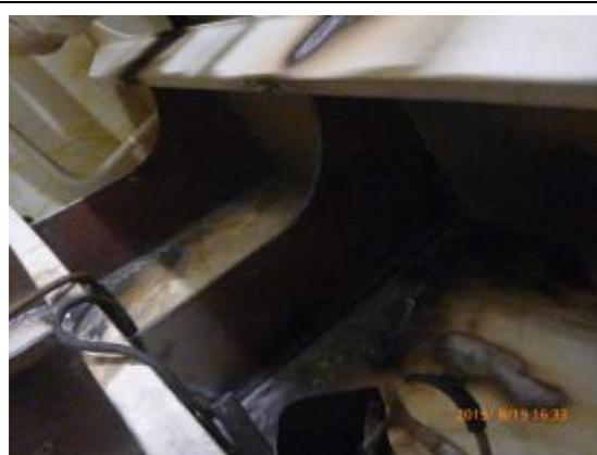
機艙左舷船體結構加強材更換
