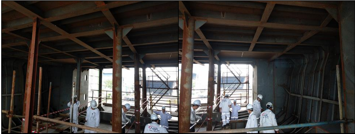
船段 B02 內部，檢視施工品質
