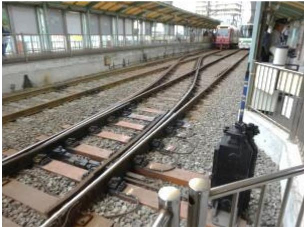
圖 29 「王子駅前」站之橫渡線設置可擠式機械轉軌器
