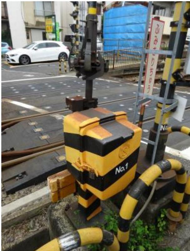
圖 39 1號平交道設置日本信號公司之遮斷機。
