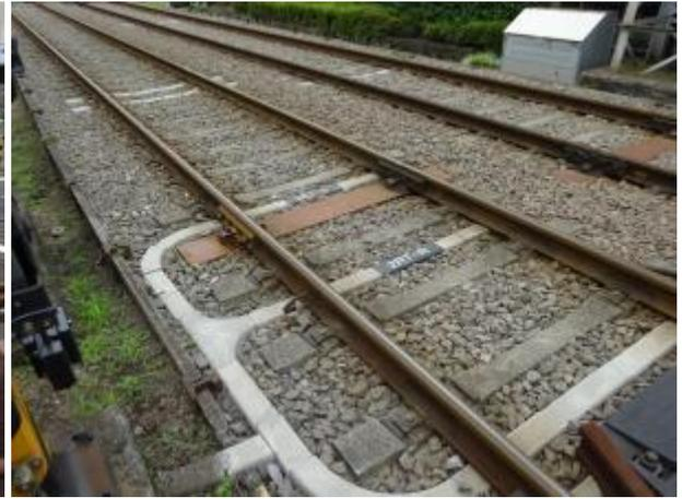
圖 41 平交道附近軌道電路纜線以水泥線槽保護。
