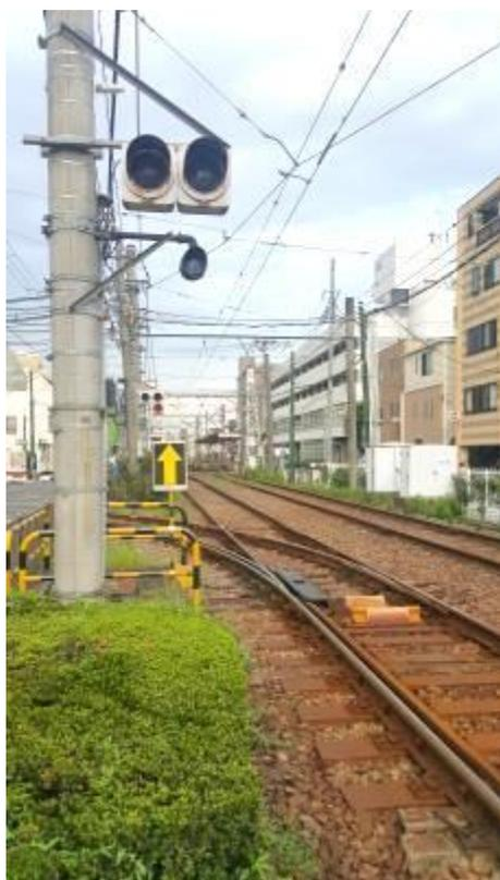
圖 48 「荒川車庫前」站進出車廠之道岔設置電動轉轍器及號誌機防護。
