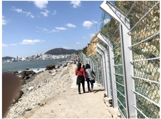
圖 30 徒步行徑旁落石區架更高之網
