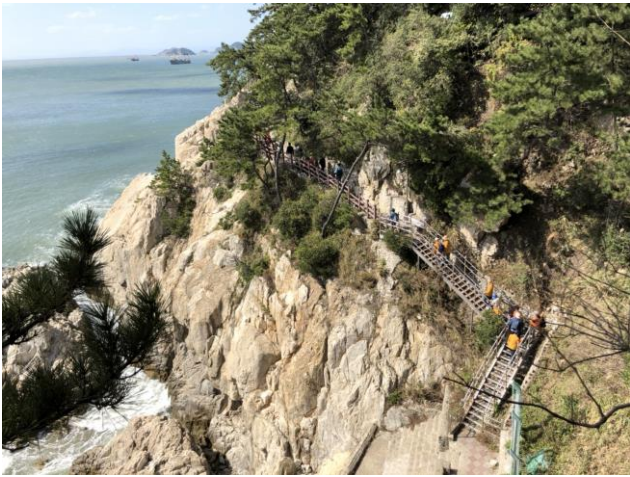
圖 33 石壁上鐵架棧道
