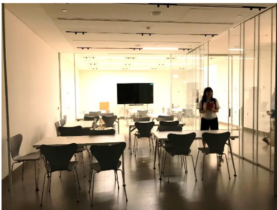
天花板軌道讓隔間板易於移動
