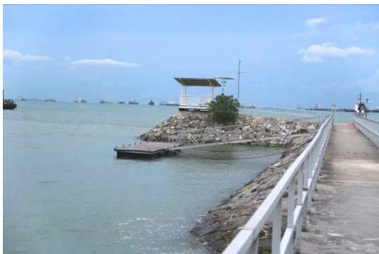
國家帆船中心－浮動碼頭及棧橋
