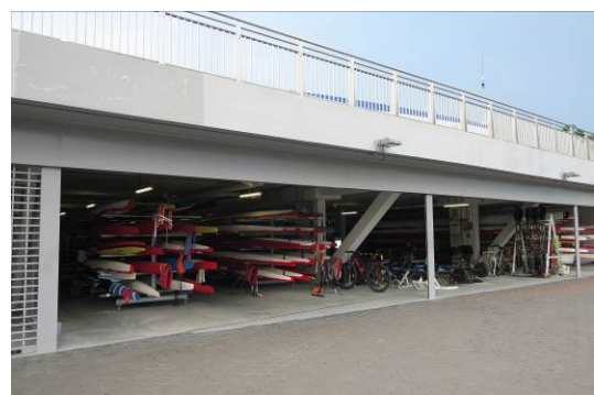
水上運動中心－平台下方艇庫
