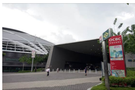
新加坡體育園區－捷運「運動場」站
