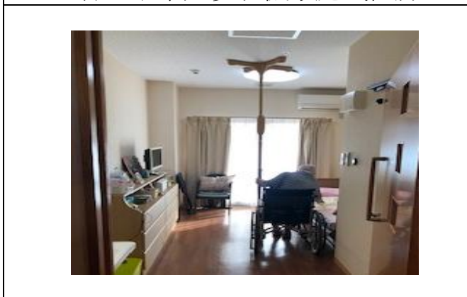
住房內設置柱型扶手方便站立
