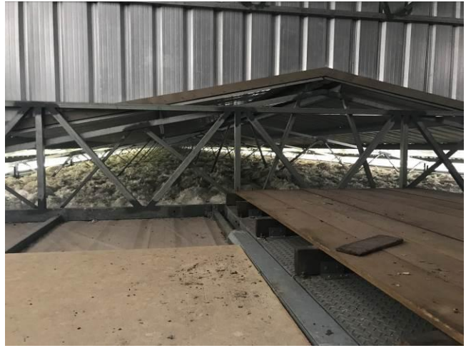
雞雞、中雞自動化禽舍與禽舍內頂部之隔熱區 間之隔熱棉
