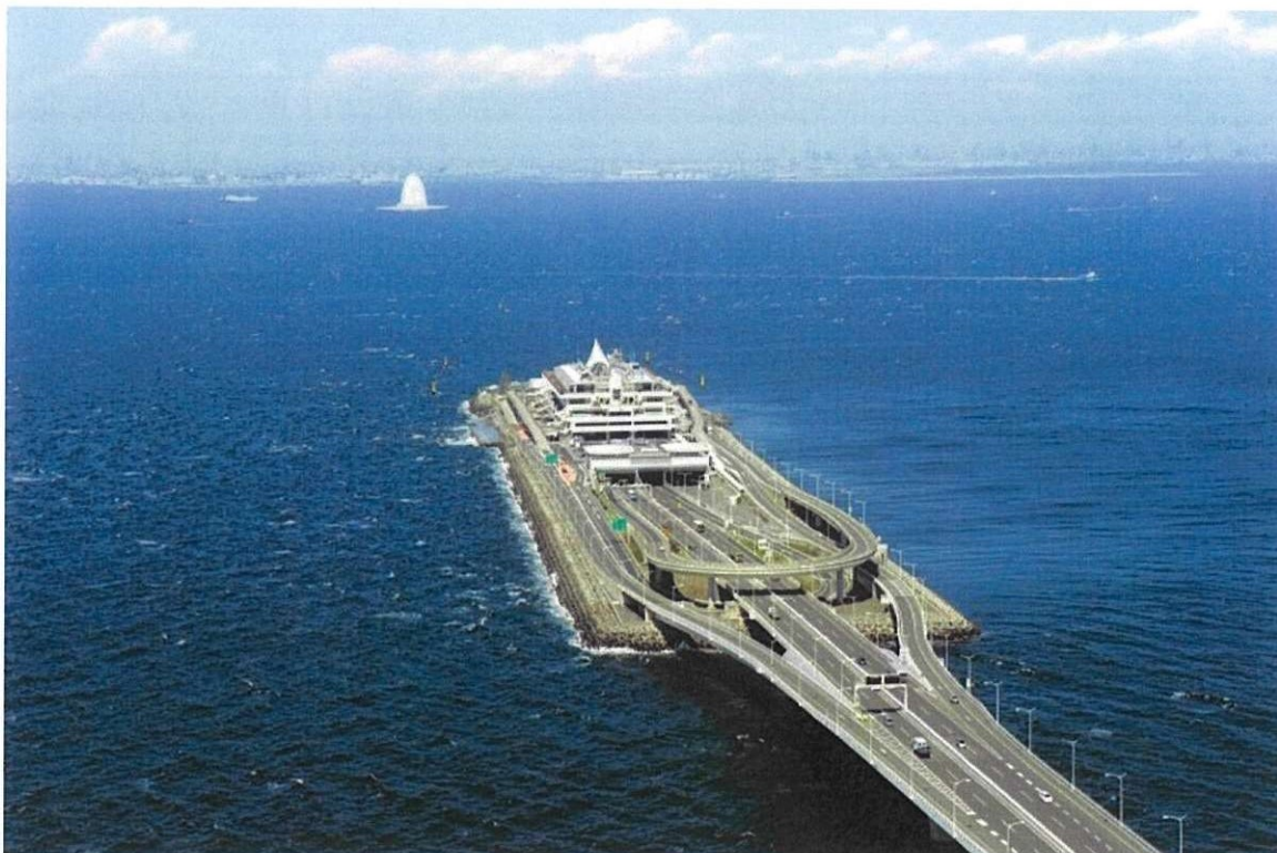
圖 14- 海螢大橋及海底隧道
