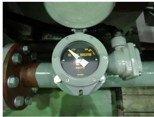
圖 3-30 油流指示計
