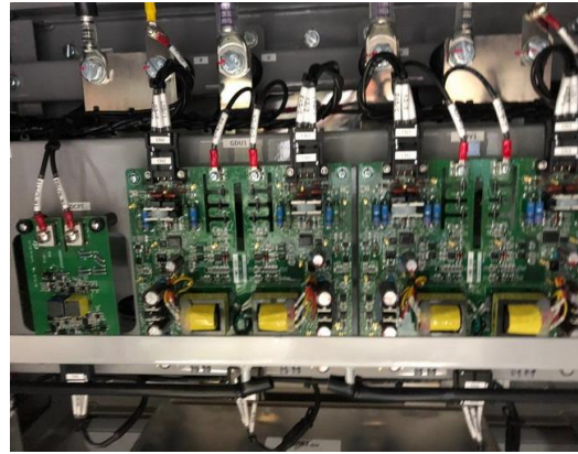
圖 3-38 本路 SIV 設備檢視(內側)
