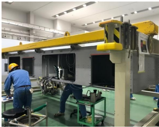
圖 3-17 作人員組件安裝
