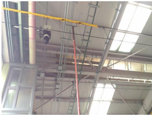
圖 5-8 接地桿掛在主吊線
