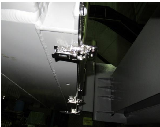
圖 4-7 箱底焊接部位檢視有無漏油
