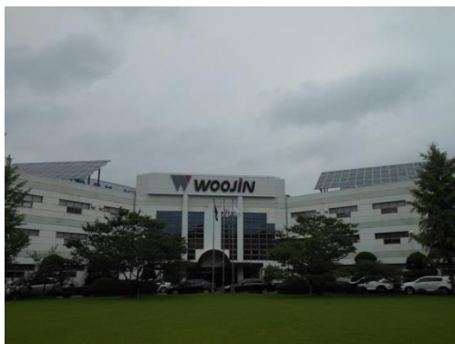
圖 5-16 宇進產電頂樓太陽能板
