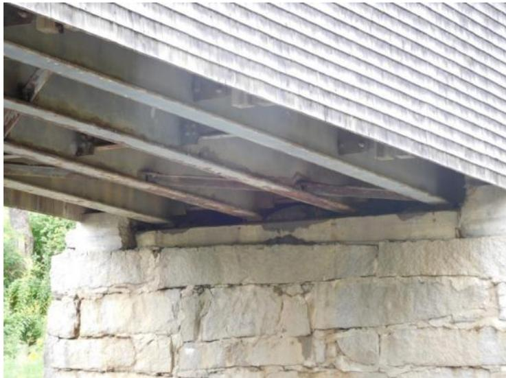
圖 49 Robyville Covered Bridge 木構造橋底部係以鋼梁支撐
