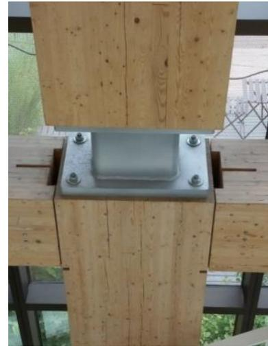
圖 39 CLT 地板與樓梯、膠合木柱梁與鋼構接合及自動撒水設備
