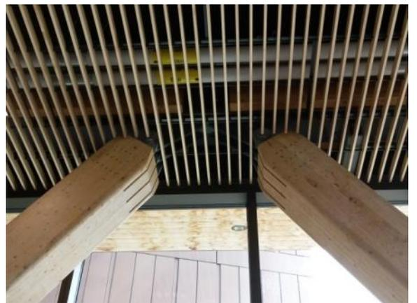
圖 38 膠合木柱梁框架、膠合木支撐框架和拉鍊桁架(zipper truss)
