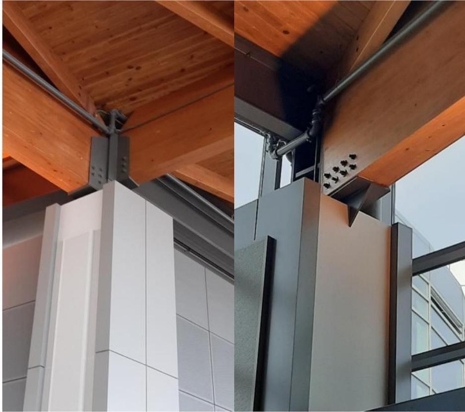
圖 57 梁、柱的接頭處理
