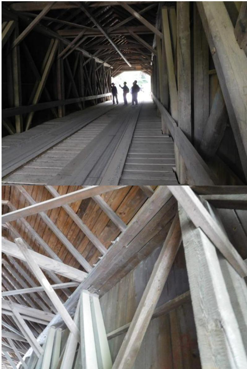
圖 50 Robyville Covered Bridge 木構造橋內部係以木構件支撐
