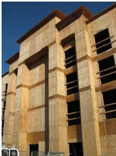
結構用合板 Structural Plywood
