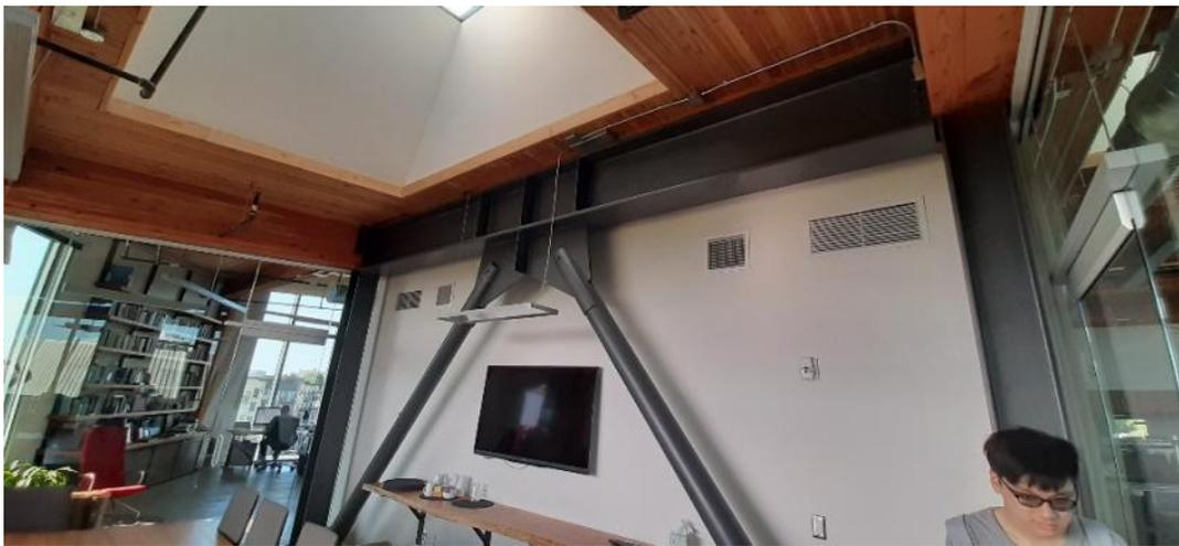
圖 74 布利特中心木構與鋼構混合構造
