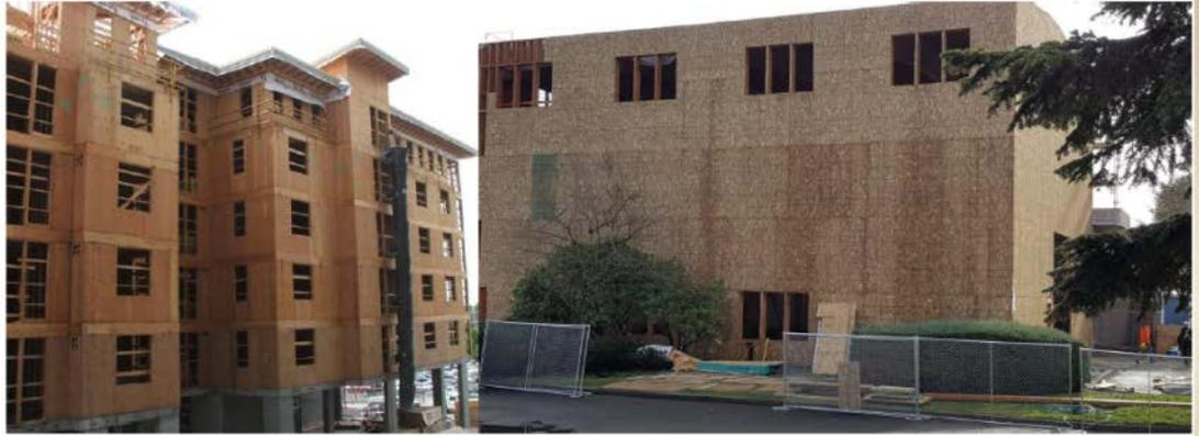
結構用合板 Structural Plywood      定向刨花板 Oriented Strand Board
