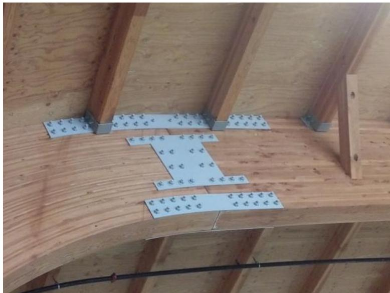
圖 88 膠合曲梁與柱之接頭以鋼板及螺栓接合傳遞載重
