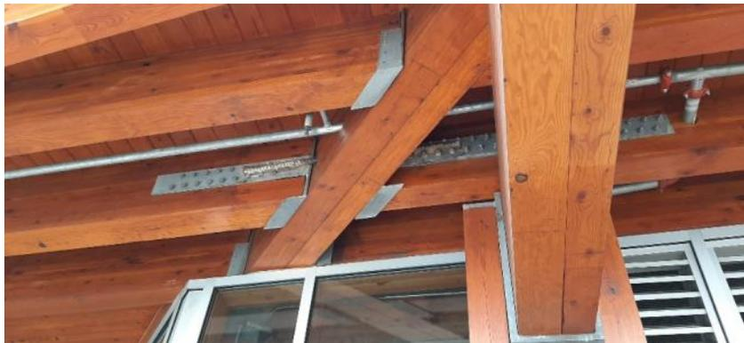
圖 79 舊爐釀造有限公司屋頂木構接合細節
