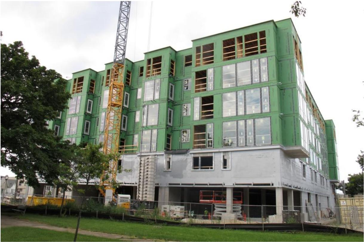
圖45 依IBC規定住宅可以興建6層樓(2層樓RC造及4層樓框組壁式木構造)
