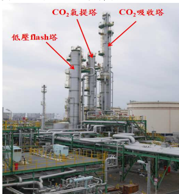
圖 3-17 苫小牧 CCS 示範計畫的 CO 2 捕獲系統
