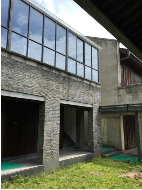
新改建完成的庫房區域。
