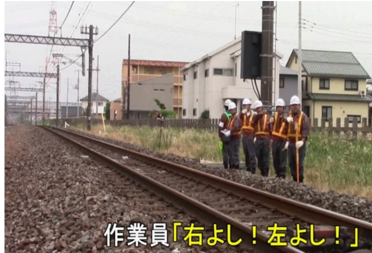
圖 42 再次進入軌道作業應確實確認左右無來車
