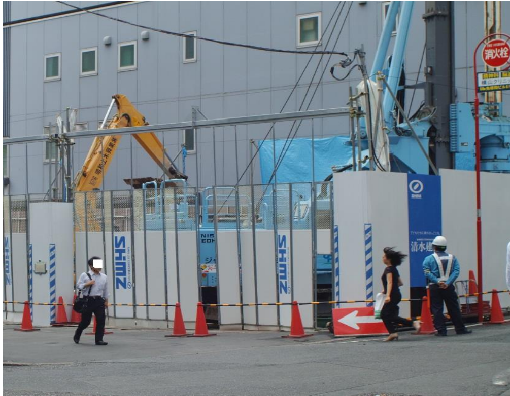
圖 6 置放交通錐及指揮人員阻隔民眾靠近工地
