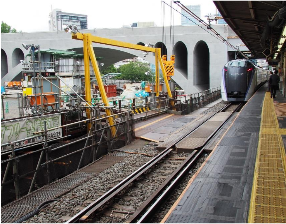
圖 22 軌道旁施工應特別防範被撞
