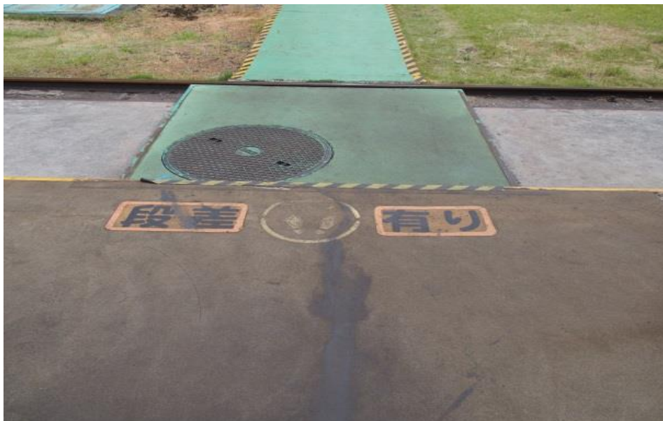
圖 32 地面高低差交接處漆上黃色油漆以提醒注意高低差
