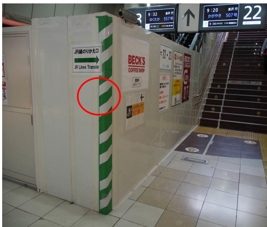
圖 49 月台施工圍籬簡潔乾淨而且於轉角修圓並輔以綠白相間之警示
