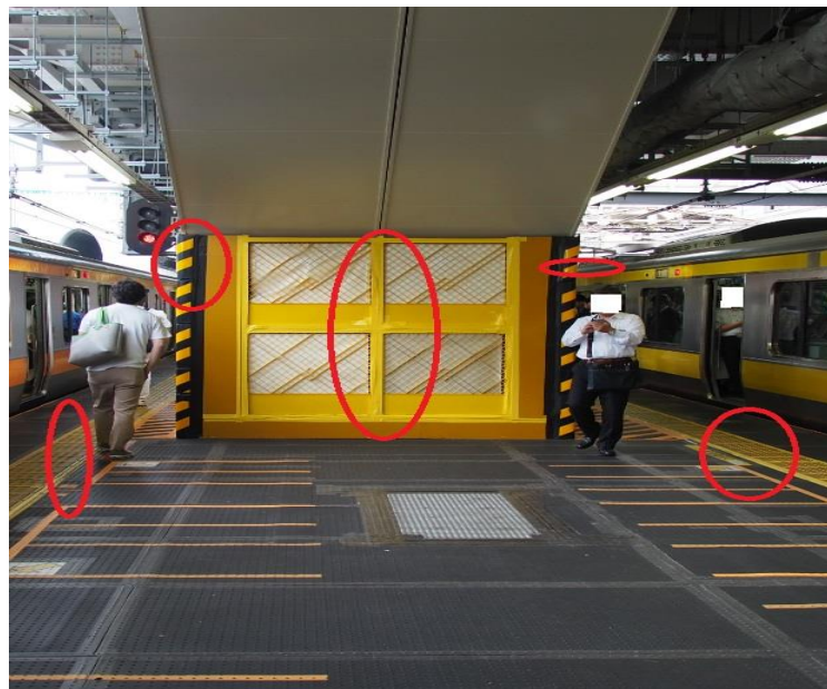
圖 21 旅客可能撞及處施設泡棉包覆及地面漆黃漆提醒小心行走
