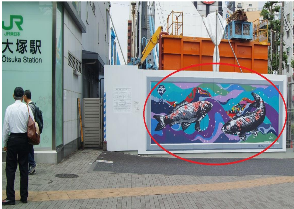
圖 5 施工圍籬美化
