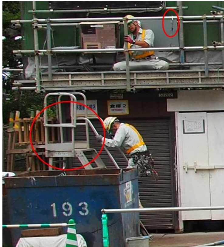
圖 20 安全上下設備及施工人員確實將身上安全掛鉤勾掛於安全母索
