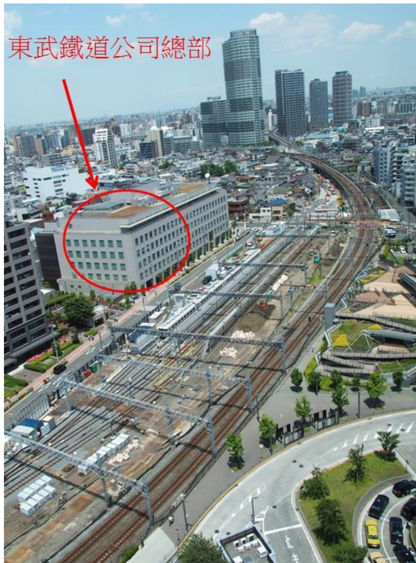
圖 45 押上站高架化工程工址鳥瞰
