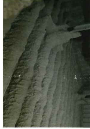
■蒸気式スートブロウ運転時
