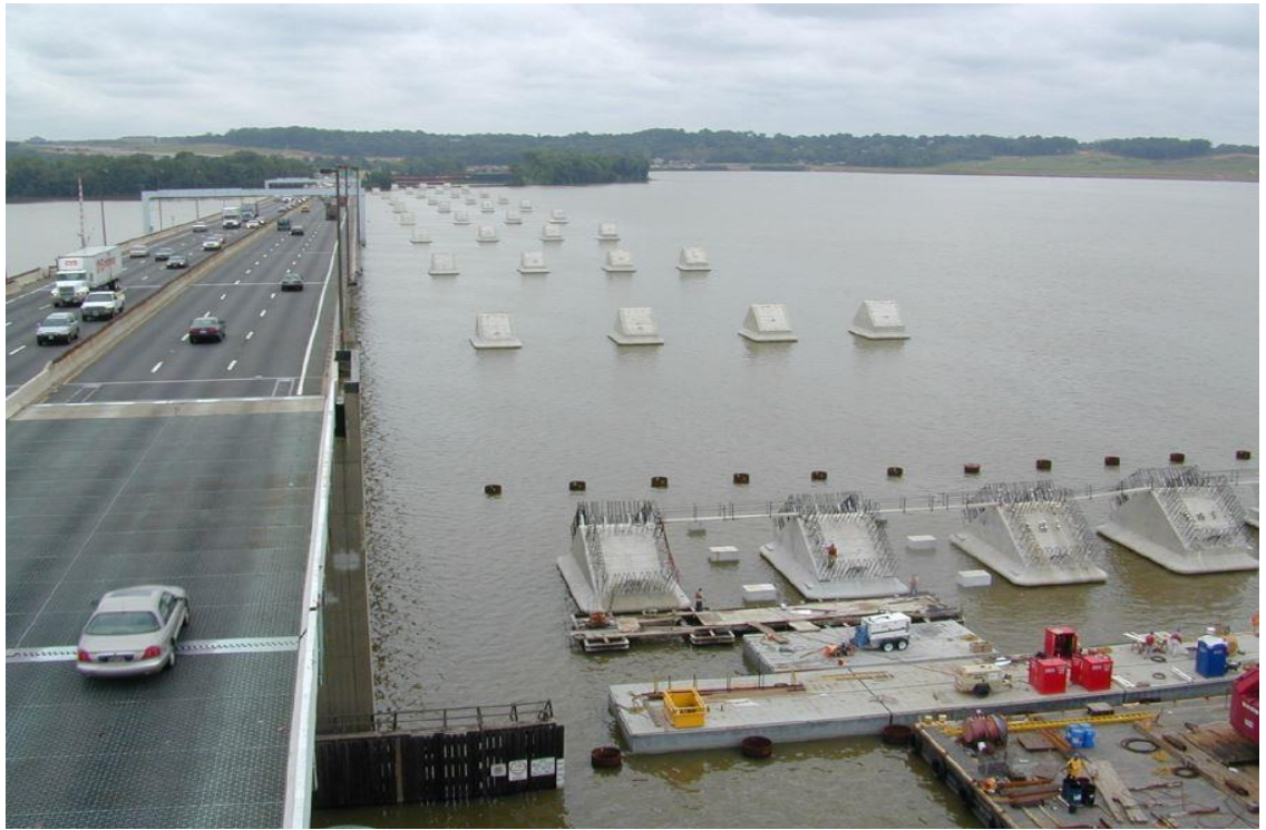
圖 3- 44 Woodrow Wilson Memorial Bridge 河中基礎施工
