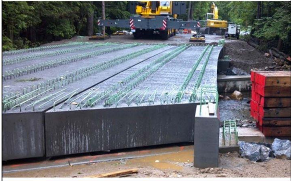
圖 3- 54 上翼板作為底模施作鋼筋混凝土（RC）橋面版
