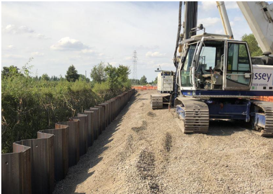
圖 3- 51 Permanent Sheetpile Wall System 施工情形
