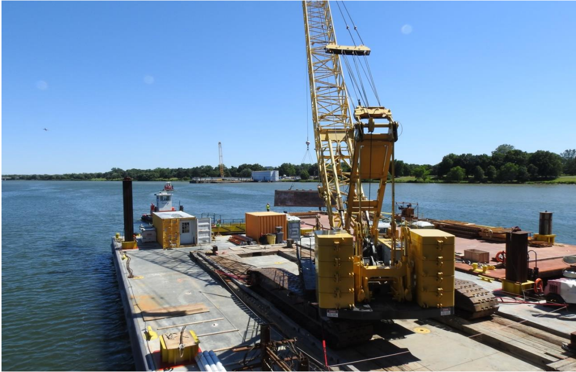
圖 3- 30 Arlington Memorial Bridge 工地使用平台船施工情形
