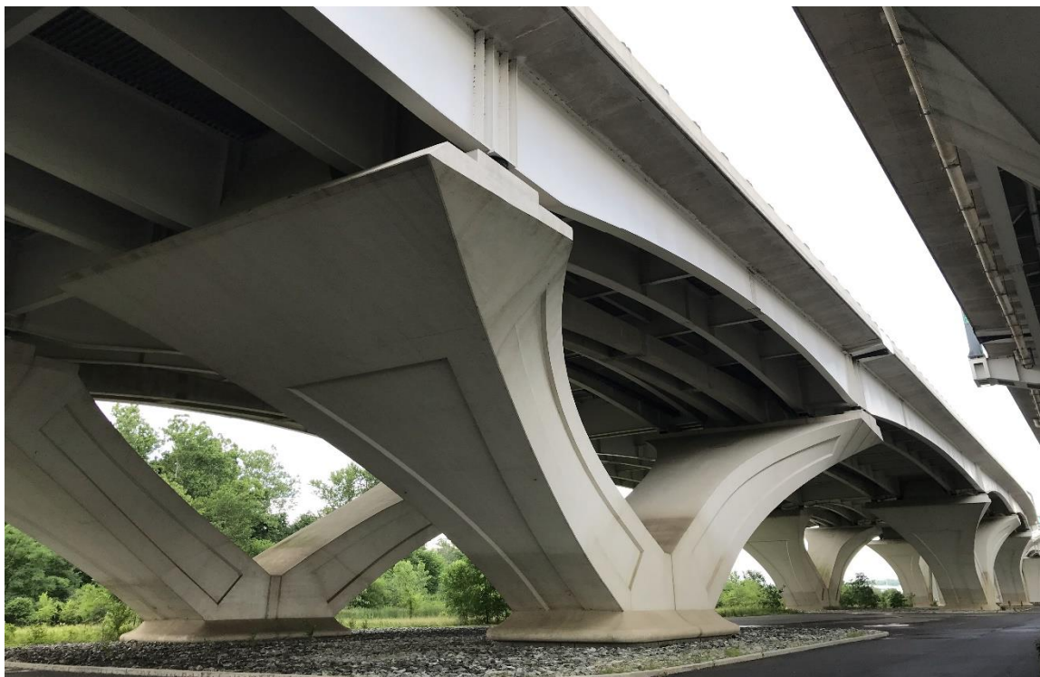
圖 3- 38 Woodrow Wilson Memorial Bridge V 型橋墩
