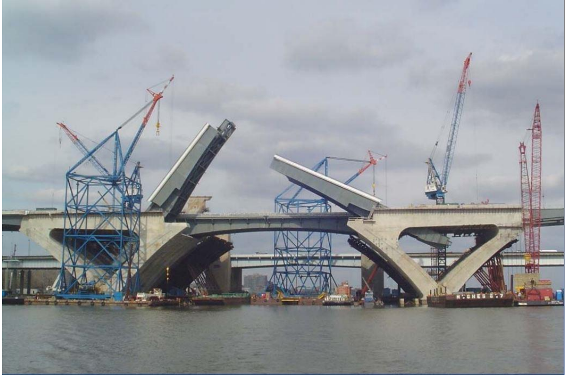
圖 3- 46 Woodrow Wilson Memorial Bridge 活動開合跨徑施工
