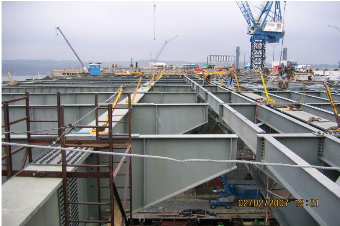
圖 3- 47 Woodrow Wilson Memorial Bridge 鋼梁組裝
