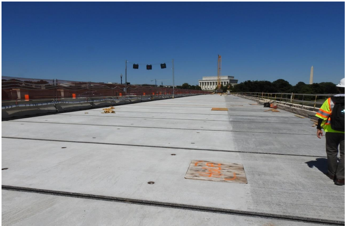
圖 3-33 Arlington Memorial Bridge 使用預鑄橋版快速工法
