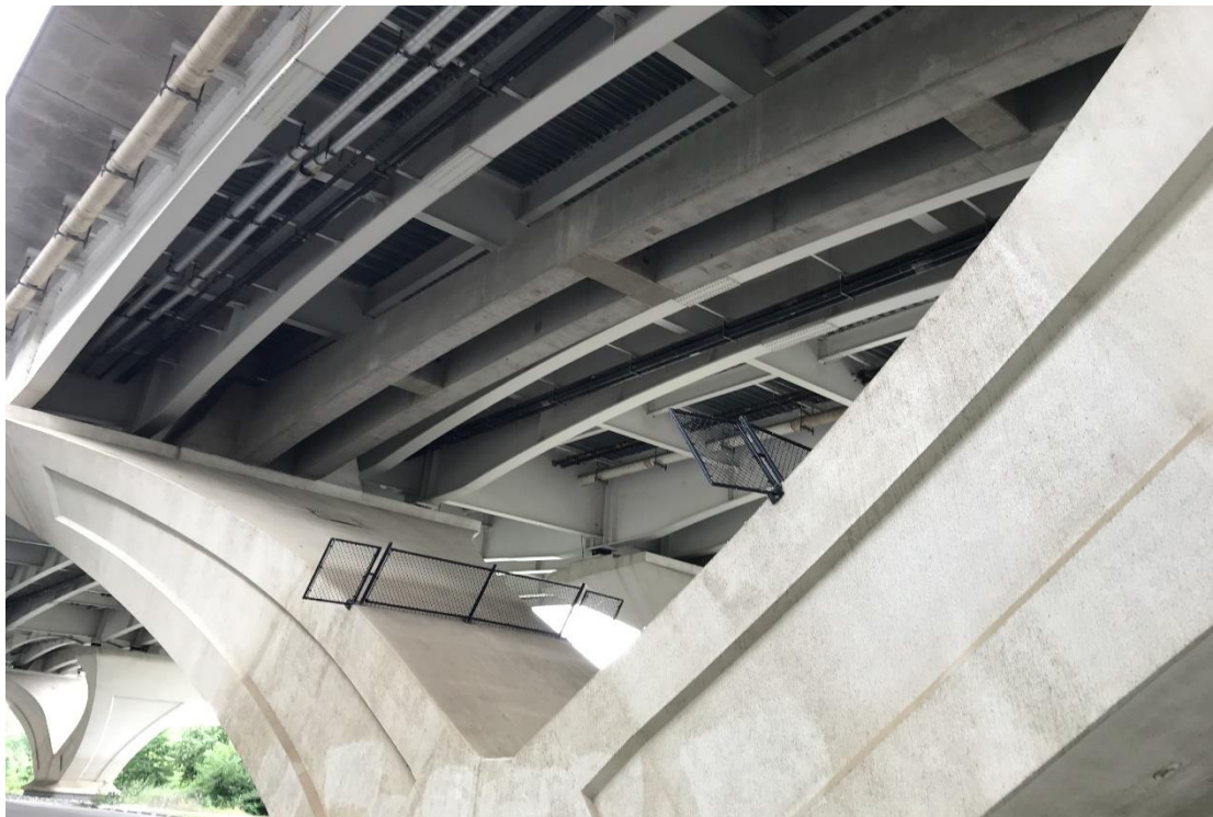
圖 3- 37 Woodrow Wilson Memorial Bridge V 型橋墩
