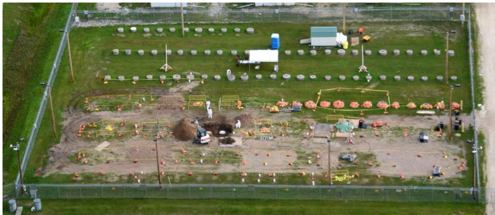
圖十、WL 地下直立貯存管區(Standpipes Area)
