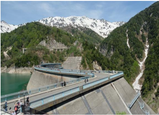
黒部川第四發電所
