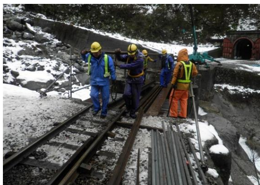
獨活谷橋拆除作業
