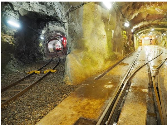
視察豎坑及內部隧道
