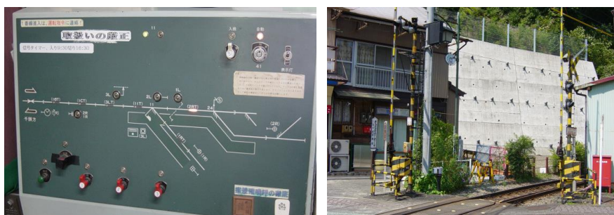
圖 7 鐵路電訊自動控制系統
