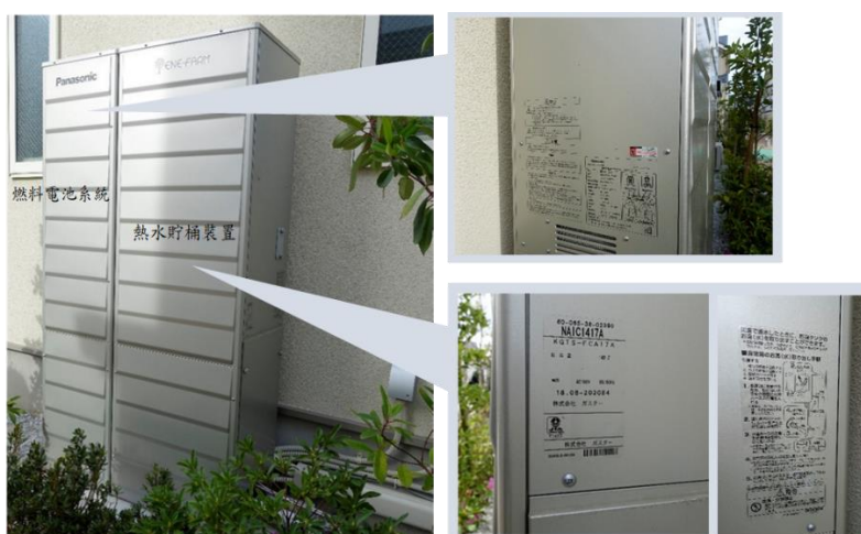
圖13 Panasonic ENE-FRAM 0.7 kW熱水供應整合型燃料電池系統
