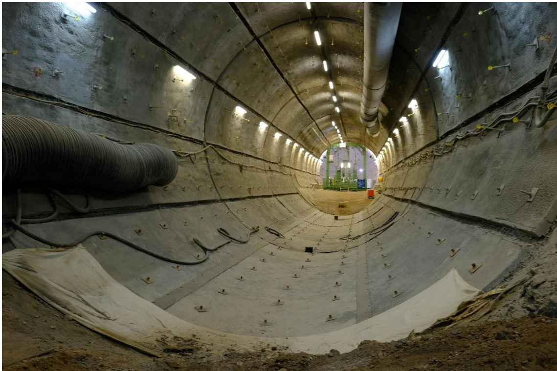
圖 60：Konrad 處置場運轉裝載設施用隧道
