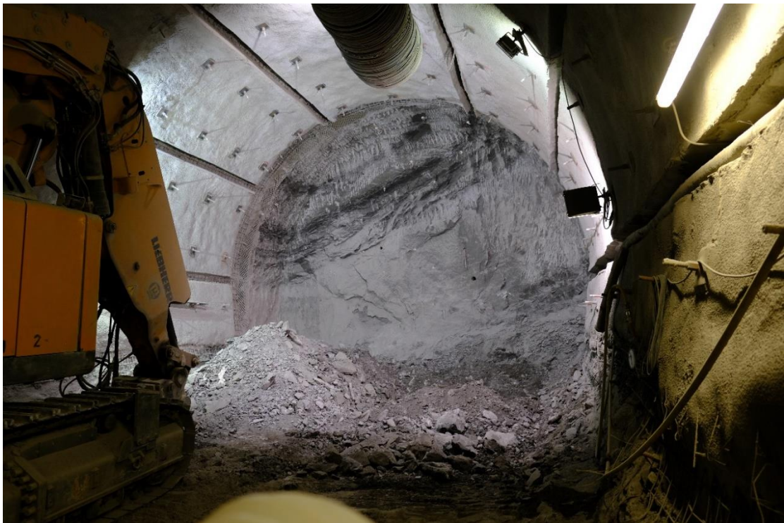
圖 58：泥岩層中隧道開挖與支撐
