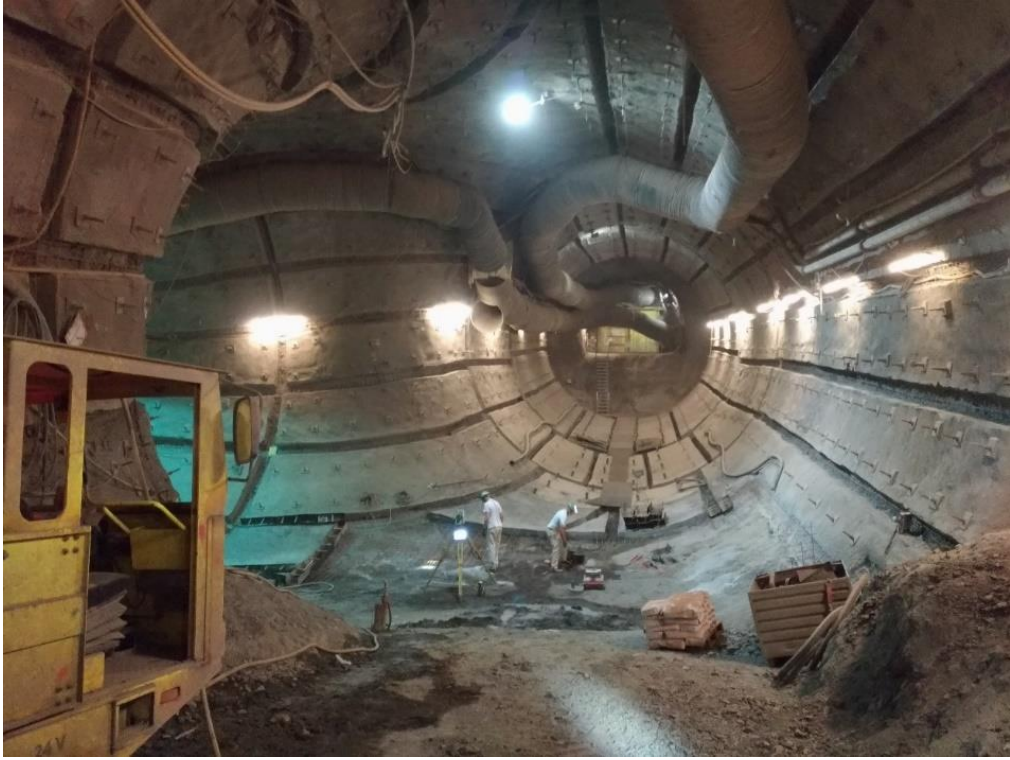
圖 59：Konrad 運轉裝載設施施工情形
