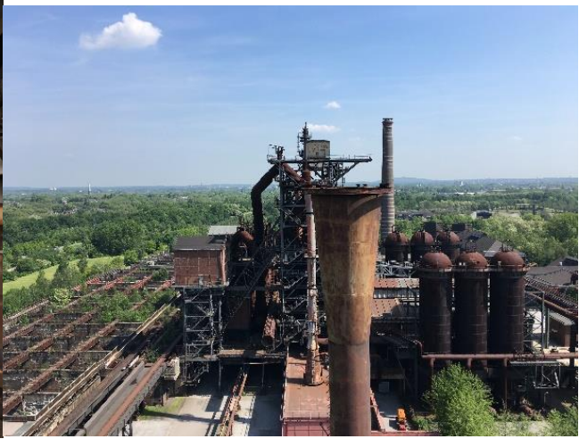
(D) 5號高爐-瞭望台
