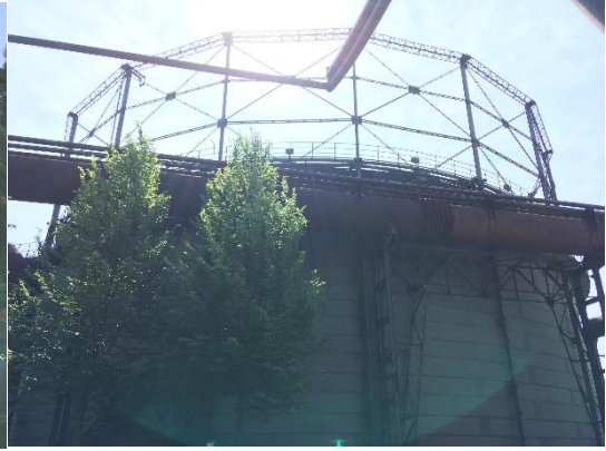
(B) 煤氣儲罐-人工潛水中心
