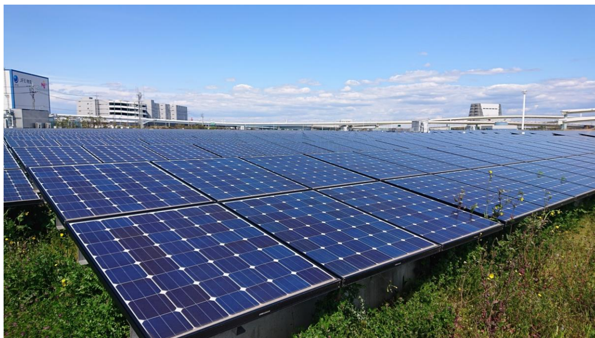
圖 31 浮島太陽能發電廠(東京電力公司)
