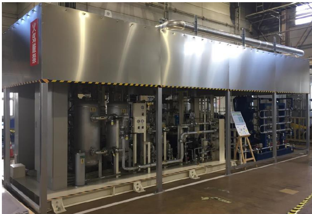
圖 3 氫氣純化裝置概要圖(廣島大學)
