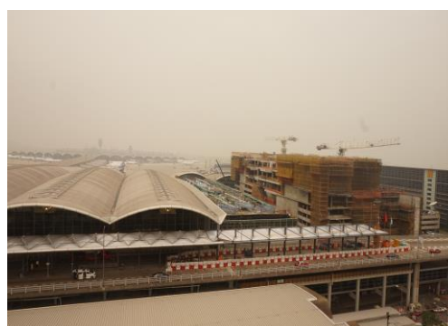
T1 及停車場大樓擴建中
