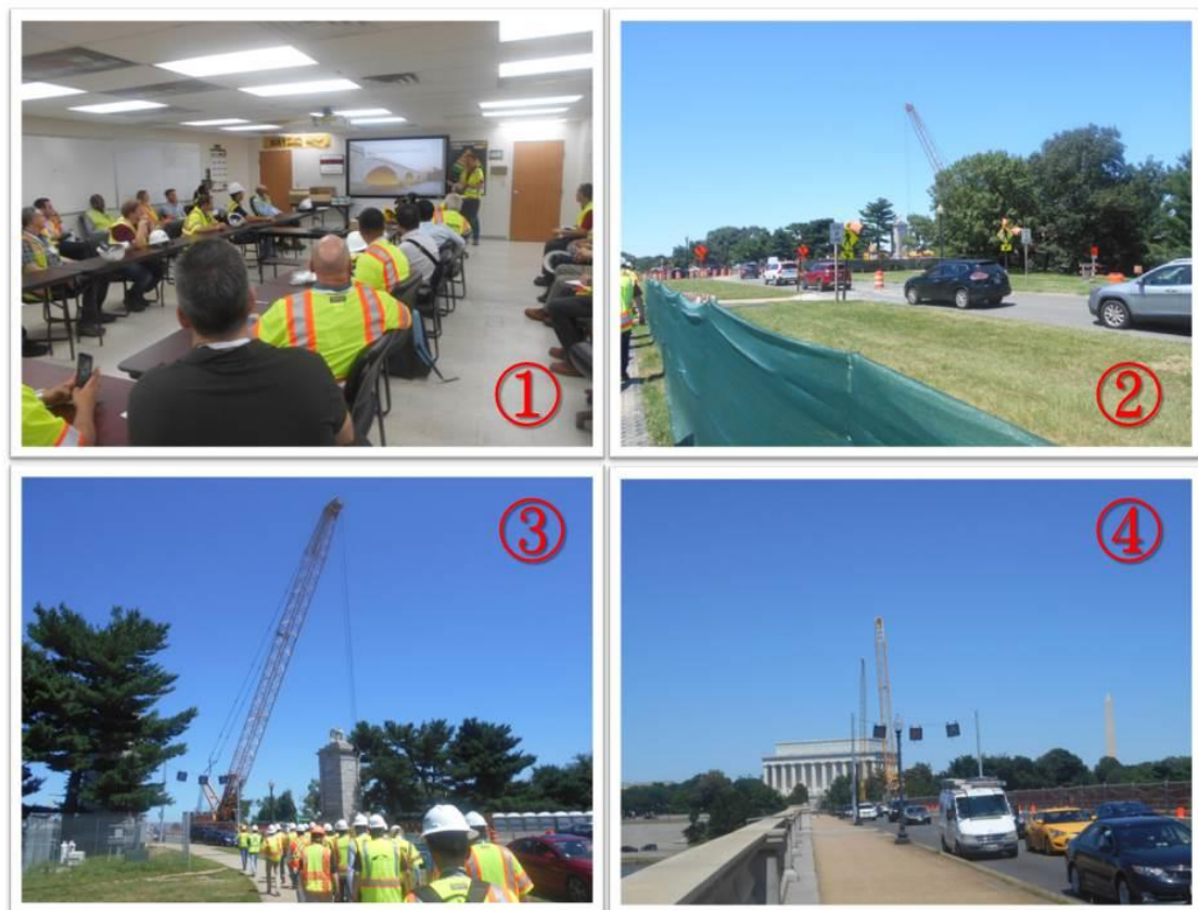
圖9 阿靈頓紀念大橋現場施工照片(一)
