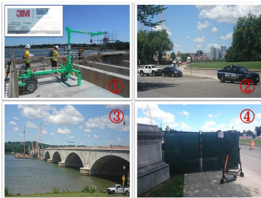
圖13 阿靈頓紀念大橋現場施工照片(五)
