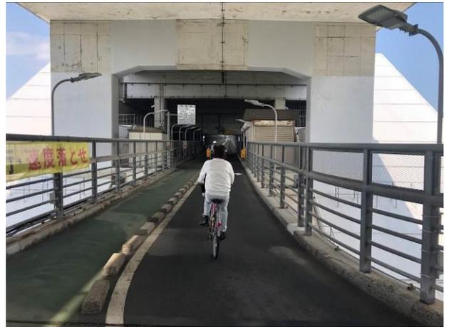
圖 4、因島大橋上、下層設計，下層供機車、自行車及行人通行
