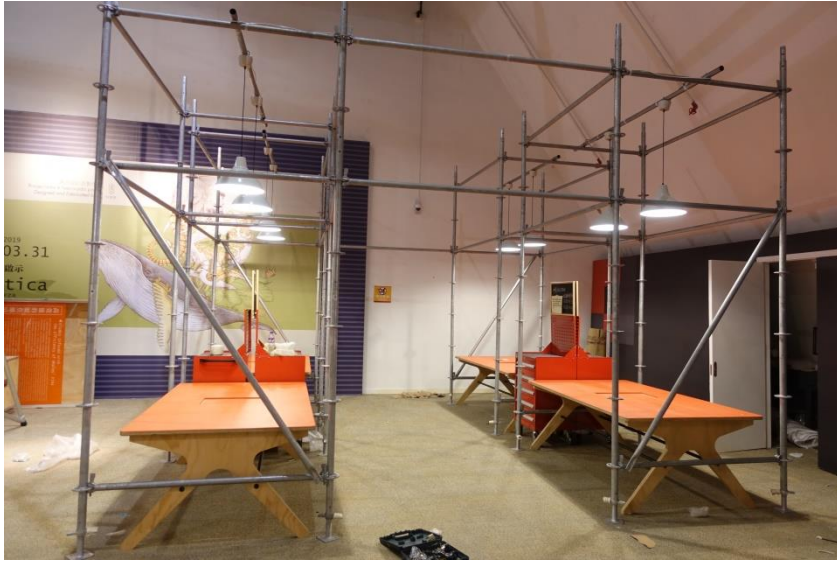
圖四、工作坊鷹架及工作桌架設完成
