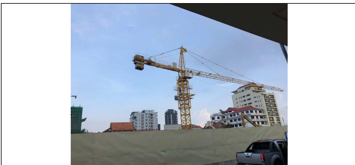
圖九：興建中之甘密醫院綜合醫療大樓。
