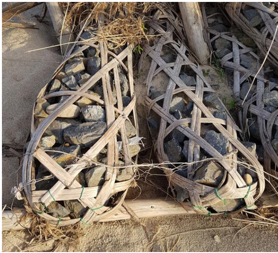
圖 45 用於定砂之竹製石籠
