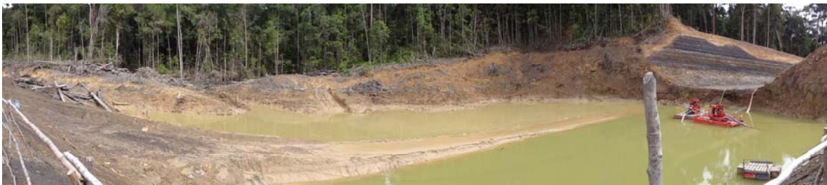
Lampunut 礦區煤礦處理廠 CHPP 蓄水池
