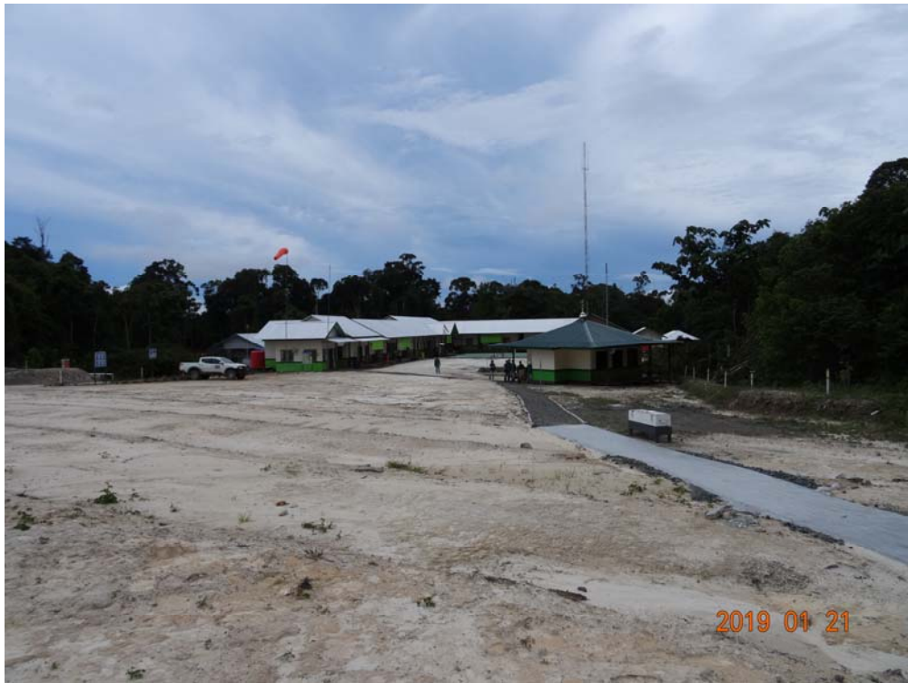
Lampunut 營區訪客宿舍
