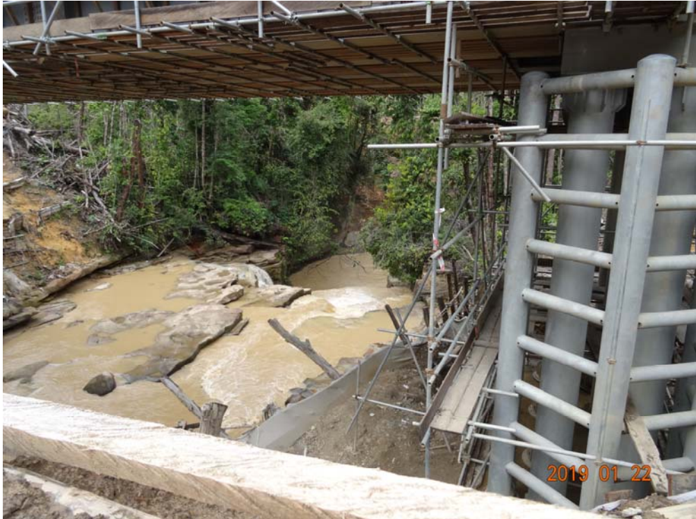
Lampunut 瀑布(橋梁下)
