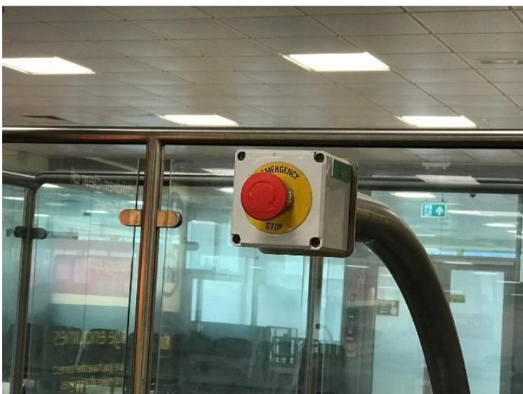
圖 60 行李轉盤設置緊急停止鈕
