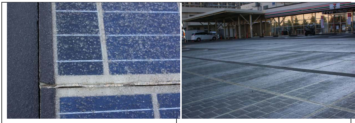
圖 3 太陽能接縫翹曲及陰影情形
